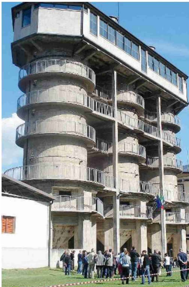
In Valcamonica. Il complesso «Tre torri» di Sellero
