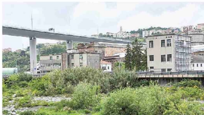
A destra l'edificio che ospiterà il murale per i vigili del fuoco FORNETTI
