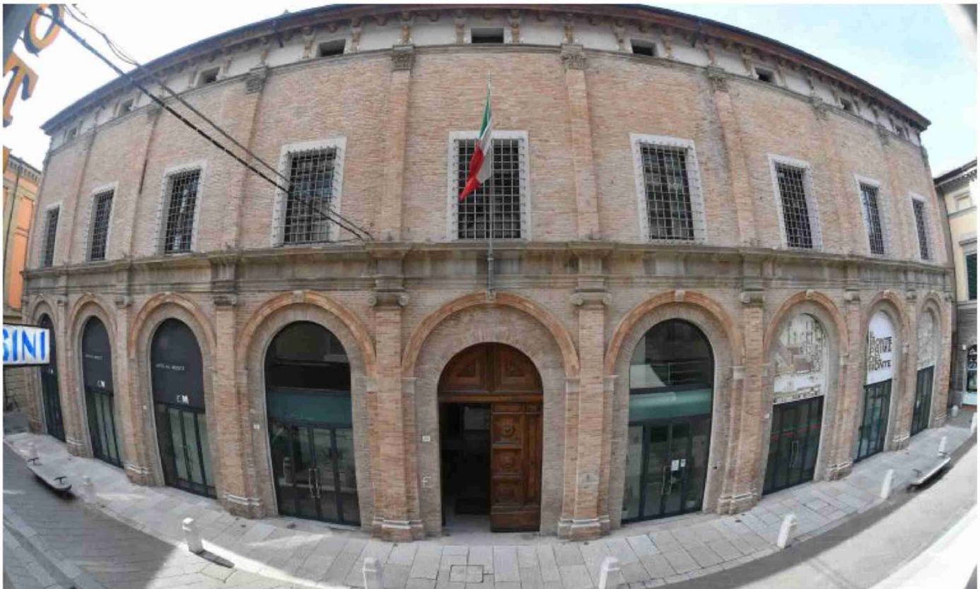
Il palazzo del Monte di Pietà, in corso Garibaldi, sede della Fondazione Cassa dei Risparmi FOTO FABIO BLACO
