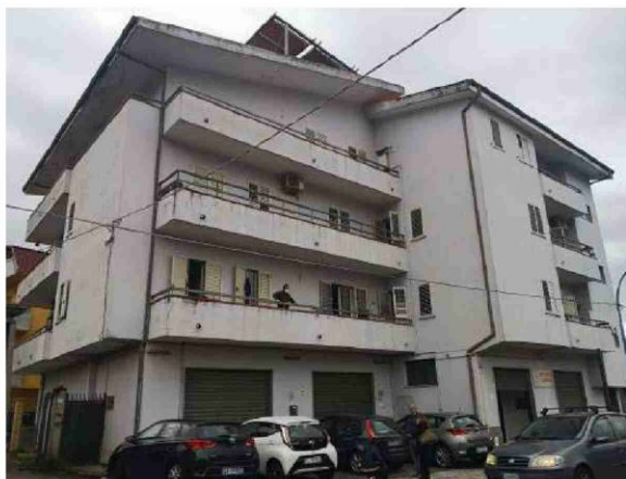
Via dei Bizantini Lo stabile confiscato e assegnato alla "Progetto Sud"
