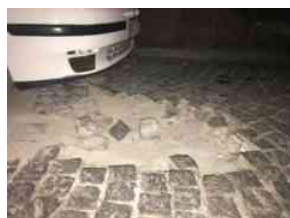
Lavori pubblici a Fabriano: nuovo look per il centro storico
