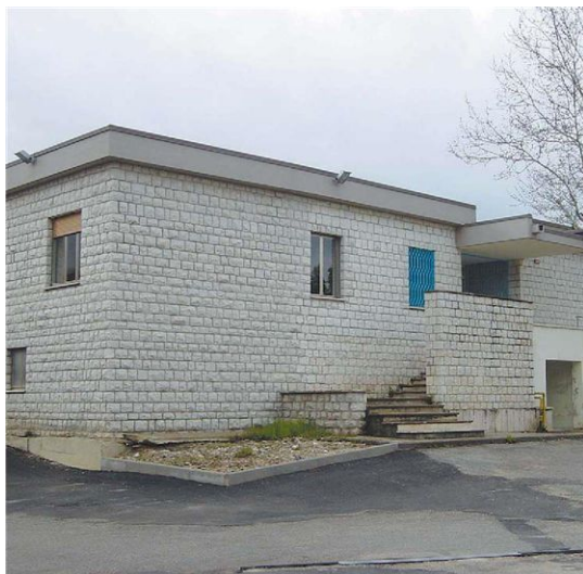
Struttura Una parte delle ex carceri di Gualdo Tadino attualmente è utilizzata dal centro di recupero socioriabilitativo Il Germoglio
