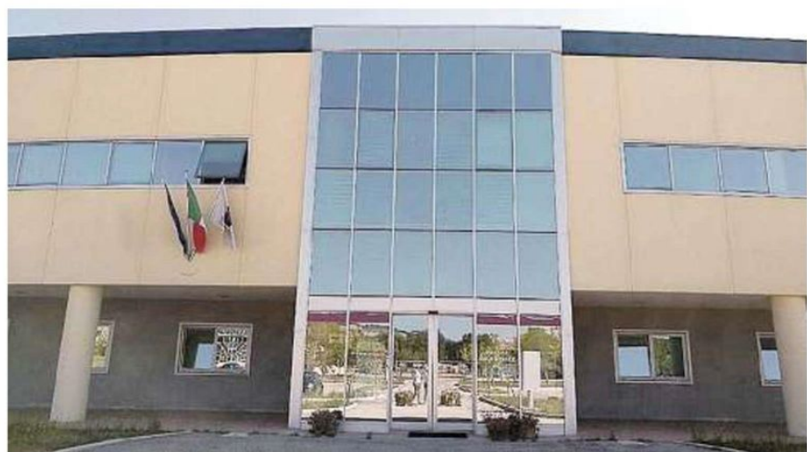
La sede dell'Unione di Pian del Bruscolo in Strada Pian Mauro
